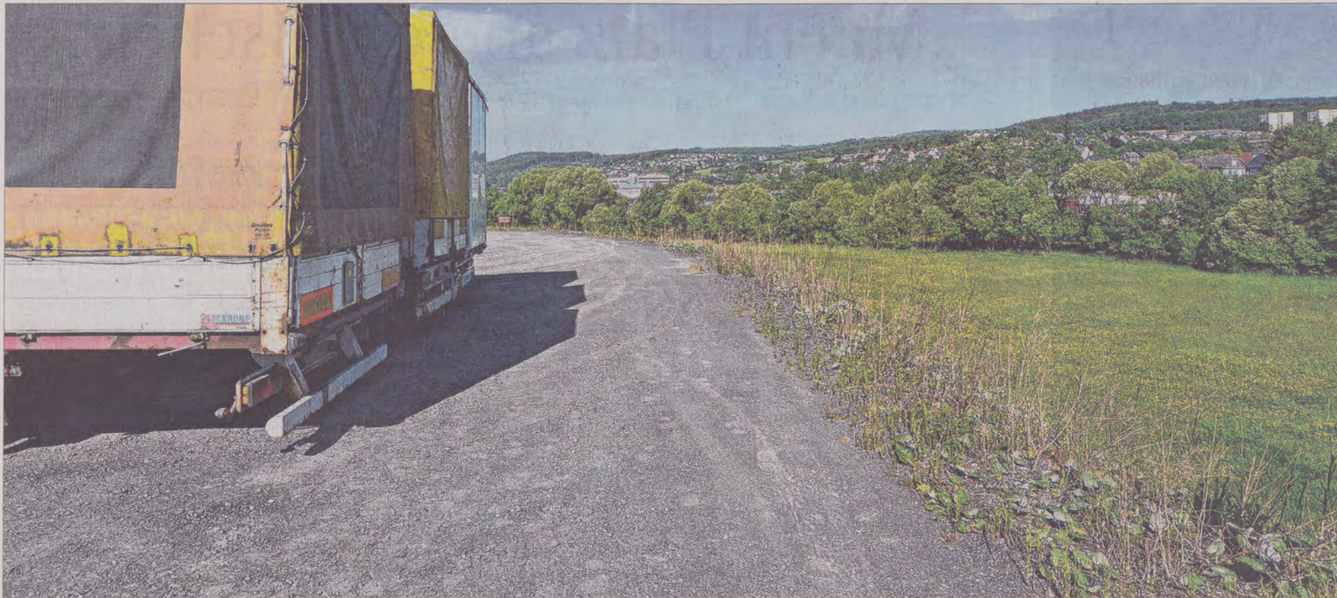
Der Parkplatz, der ungefähr die Größe eines Fußballfeldes einnimmt, wurde völlig ohne Baugenehmigung in das naturgeschützte Wiesental geschüttet.
